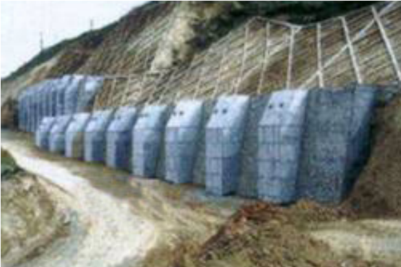
图2-1-8 防止山体滑坡的抗滑桩
